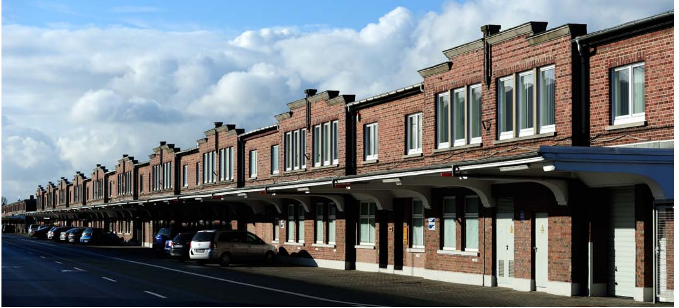
Lebendige Industriearchitektur aus den 1930er Jahren: Die Halle XIV ist eines der ältesten Industriegebäude im Fischereihafen.
