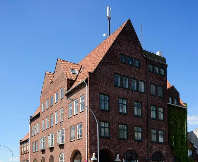
Das 1913 errichtete Seemannsheim zählt zu den prägenden historischen Bauten im Fischereihafen.
