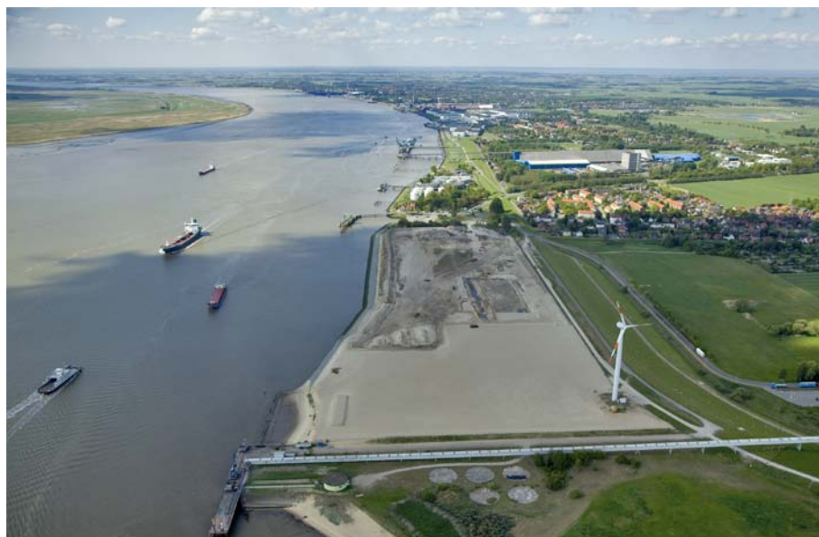
In Nordenham finden Hersteller und Zulieferer Gewerbeflächen mit einer branchenspezifischen Infrastruktur – und das direkt am seeschifftiefen Wasser.
