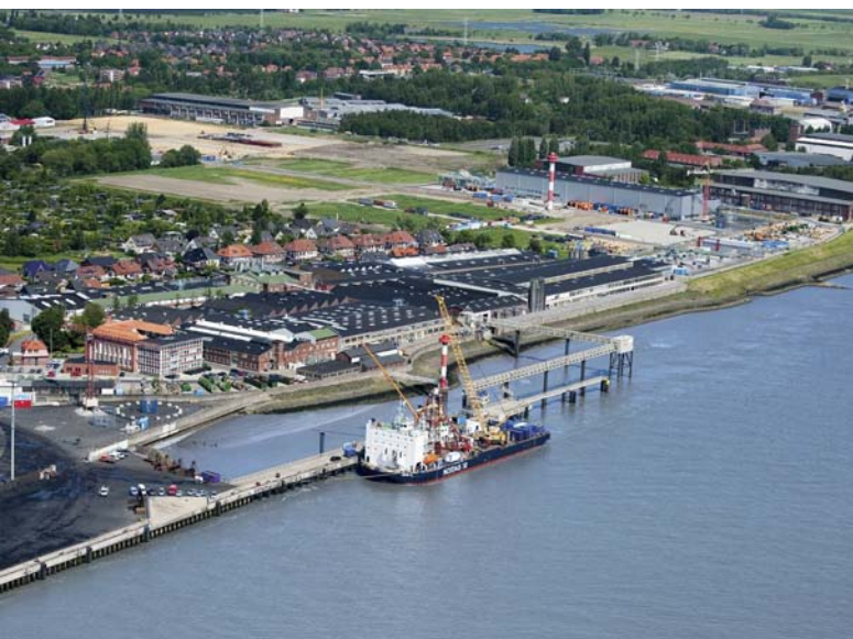
Kabellegerbarge „Nostag 10“ bei der Verladung von Seekabeln an der NSW-Werkspier in Nordenham.
